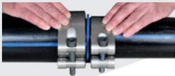
Schellen bündig mit den Rohrenden positionieren.
