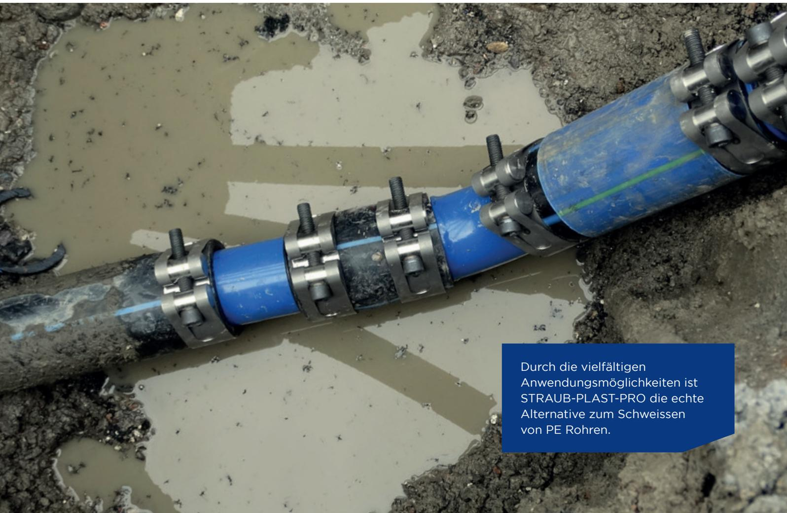
Durch die vielfältigen Anwendungsmöglichkeiten ist STRAUB-PLAST-PRO die echte Alternative zum Schweißen von PE Rohren.
